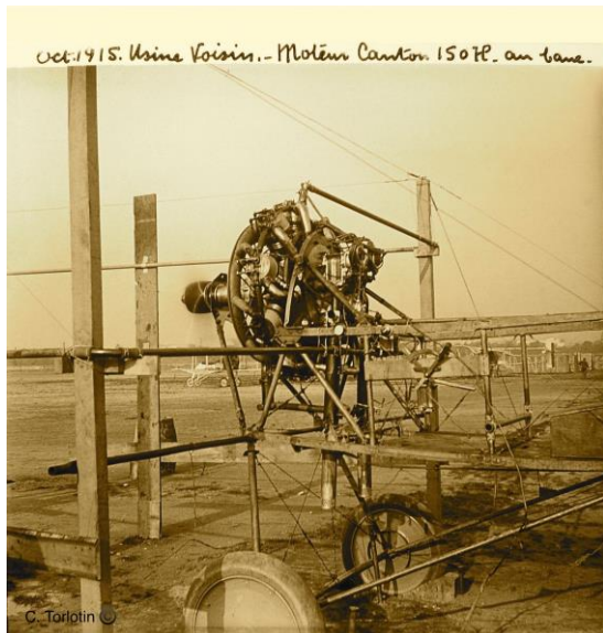
Octobre 1915 – Moteur Canson 150 cv au banc
