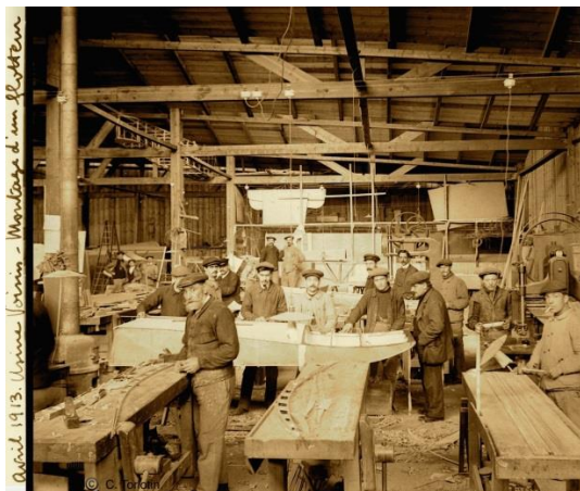
Montage d'un flotteur d'hydravion
